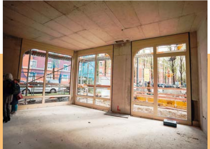
Der Eingangsbereich im Erdgeschoss des Sternenhauses
