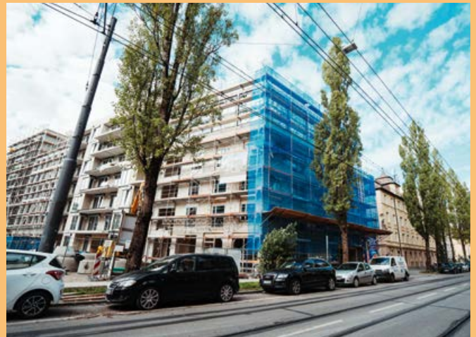
Die Sternenhausfassade von der Regerstraße aus gesehen
