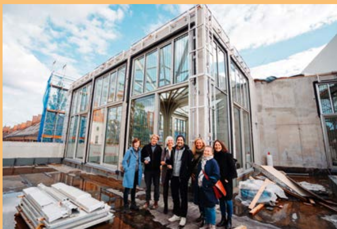
Das Stiftungsteam zu Besuch auf der Baustelle
