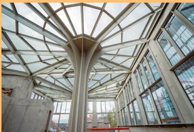
Die Dachkonstruktion des Sternengartens ist fertig
